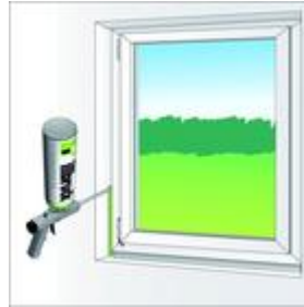
Ilustracja 3: Wypełnić pianką fugę okienną
